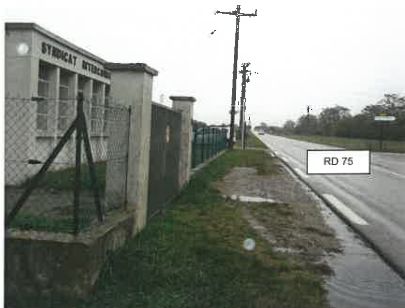
Accès à la station de pompage (parcelle n°49 AB)
