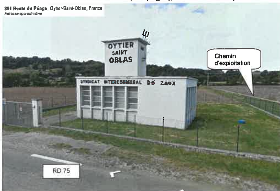
Figure 2 : Planche photographique de la station de pompage de la Plaine
