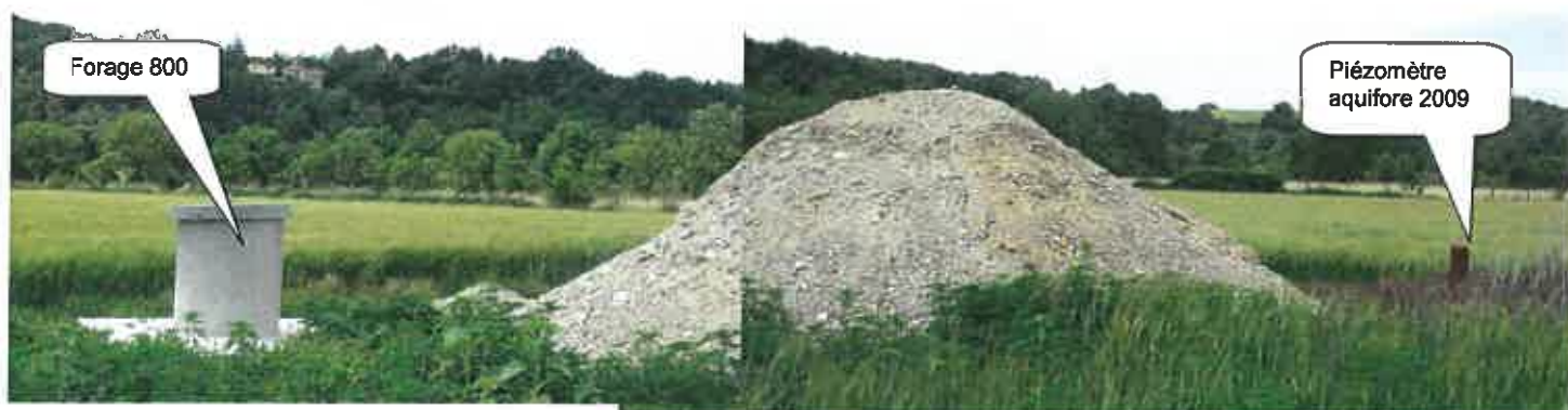
Figure 6 : Clichés de l'ouvrage DN 800 2011 pris en juin 2012
